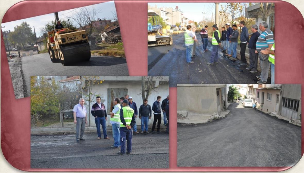
( ASFALT YOL ÇALIŞMALARI )
